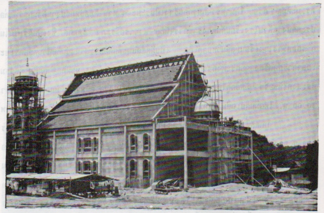
ดร.มะห์มูด กาชิม ได้เดินทางมาตรวจการก่อสร้างอาคาร ครั้งที่ 3 เมื่อเดือน มิถุนายน 2530
