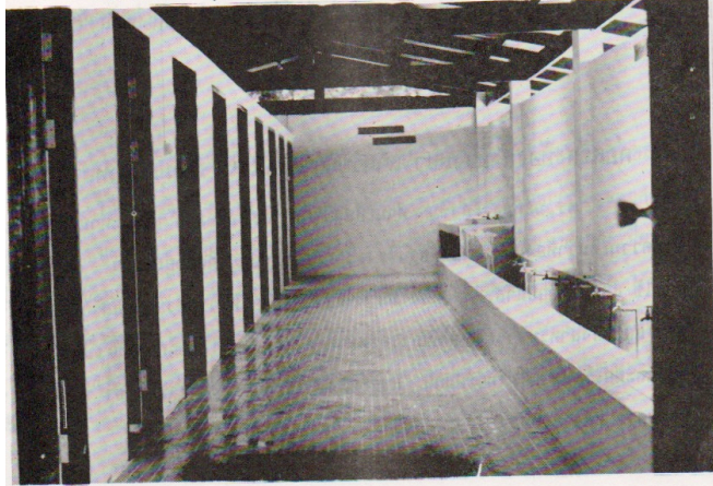
ภายในห้องน้ำ ห้องสุขา และสถานที่สำหรับชำระล้างก่อนการละหมาด
